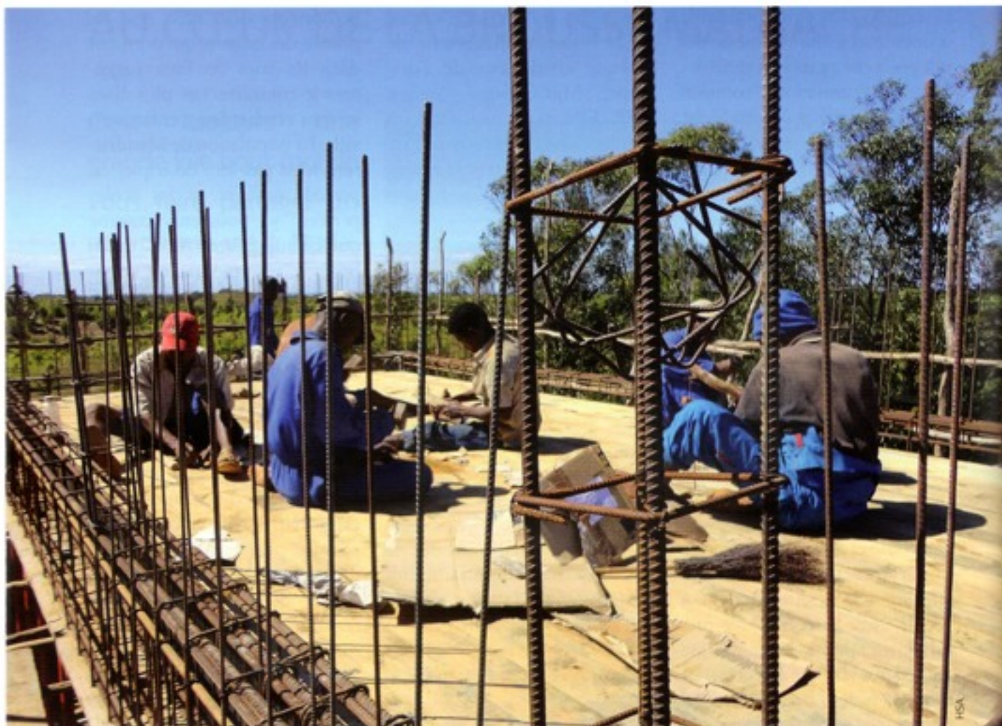
Cela se fait dans le temps et bien puisque nous sommes, ici, au premier calfatage du coffrage de la seconde dalle qui portera les citernes.
