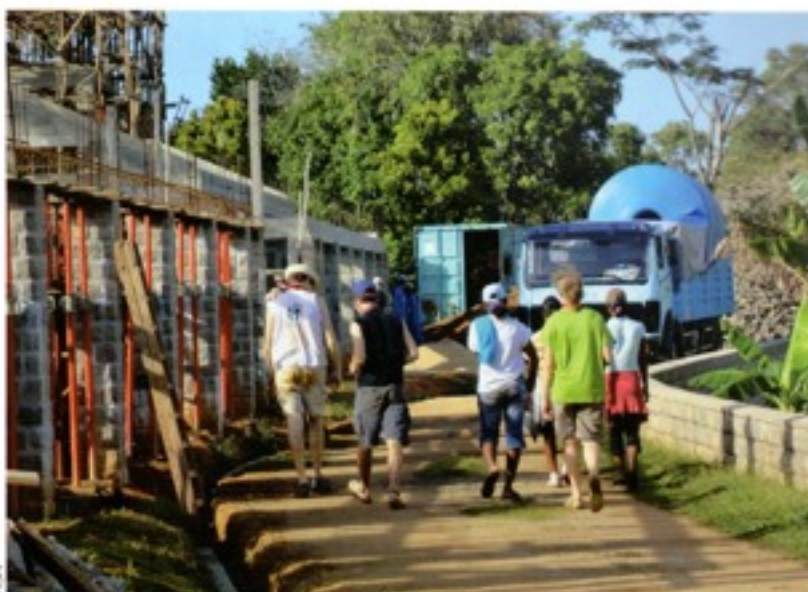
Des scouts de France de Tours se sont mis à la disposition du chantier pendant 15 jours.
