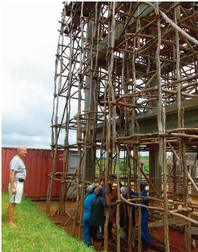
Étape importante de la pose de l'échelle sécurisée sur le château d'eau.
