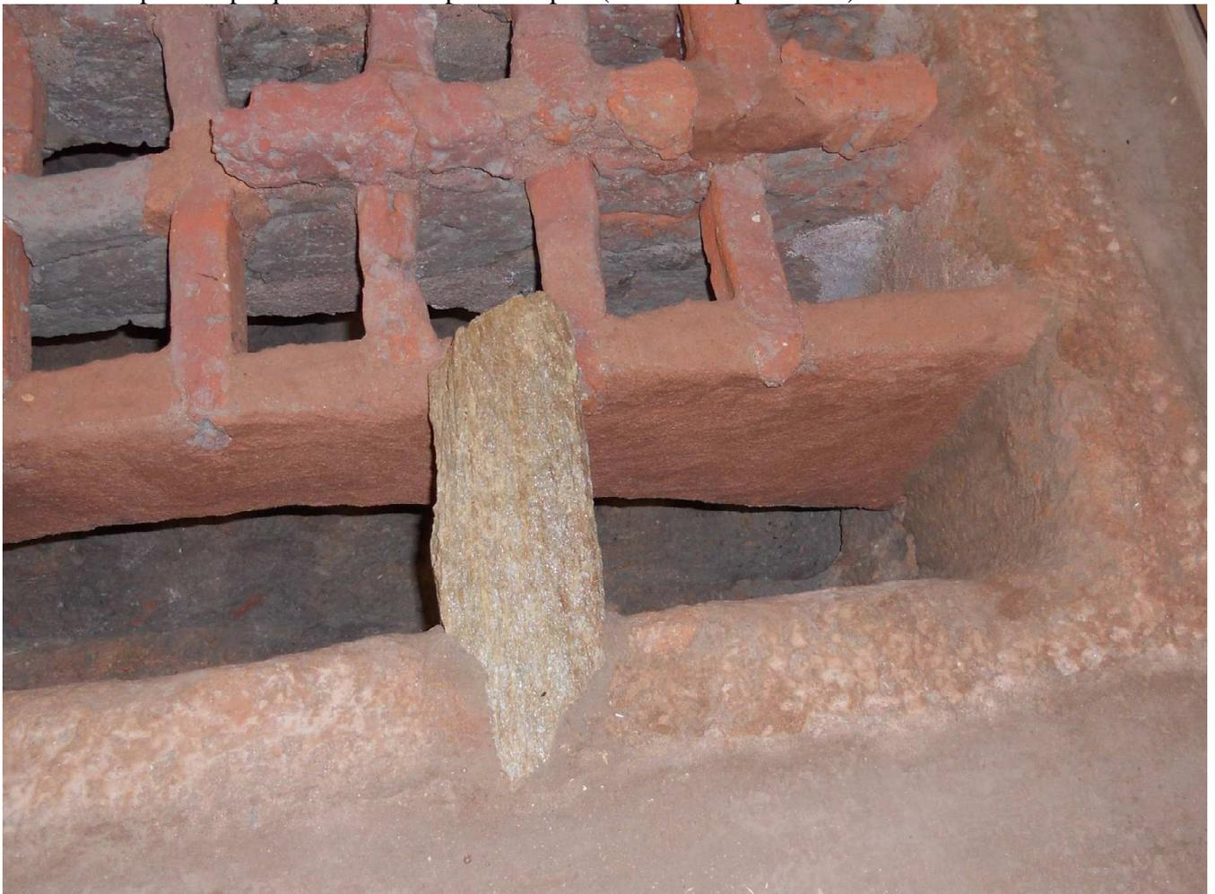
*En bas de la photo, on peut visualiser une cheminée avec ses membranes verticales en schiste de canalisation des fumées ; en haut, on constate un exemple de rehaussement par réparation rechapage)*
