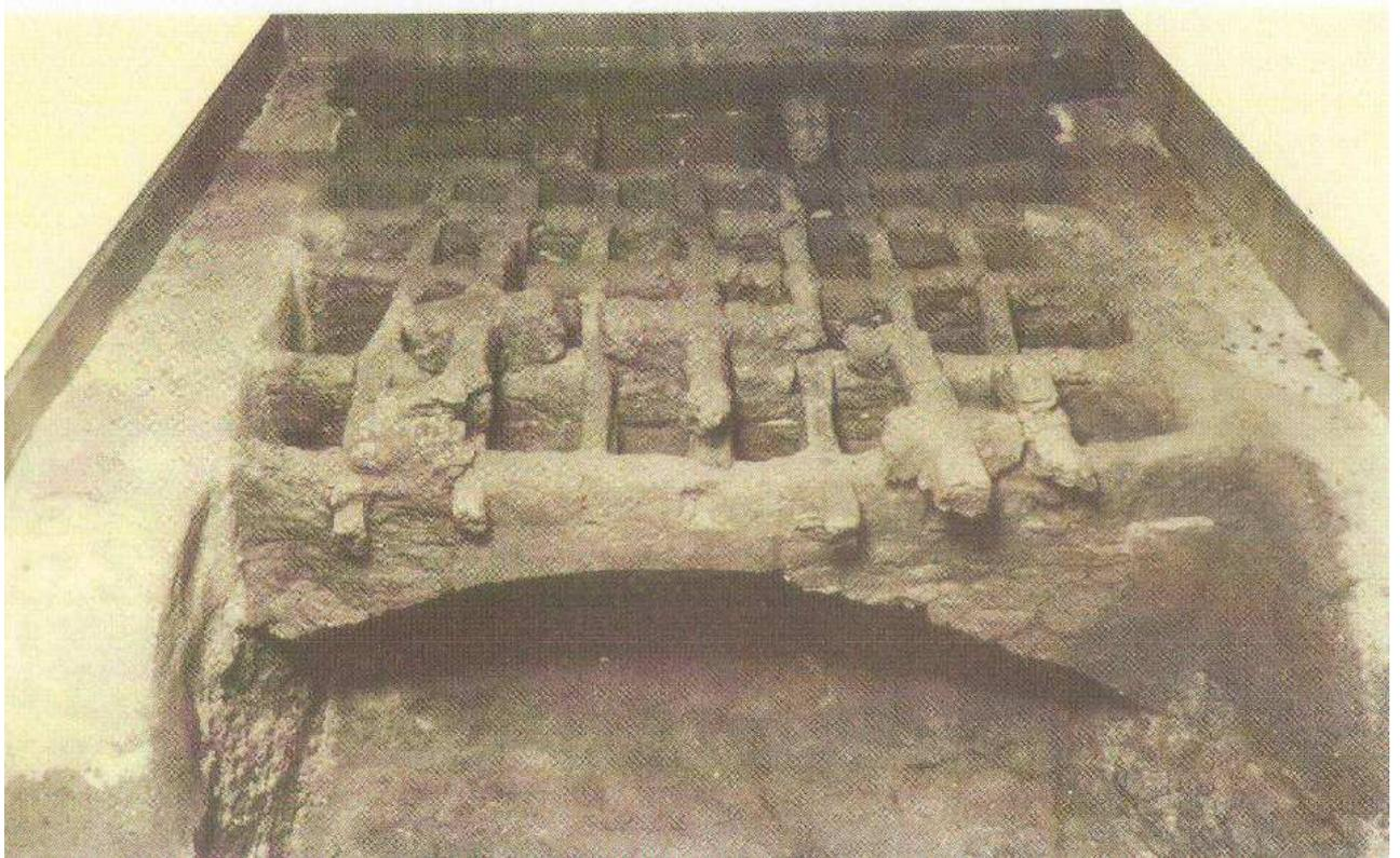
Il apparaît qu'il y a 2100 ans environ, la construction des fours à grilles était très au point. Le four en argile était creusé, construit et cuit sur place, à un endroit judicieusement choisi.
