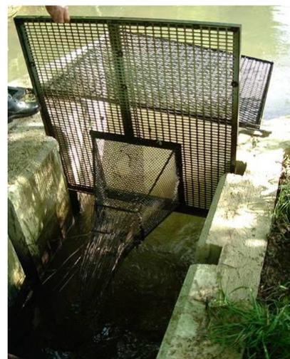
*Exemple d'un dispositif de gestion du niveau de l'eau servant également de piège*
