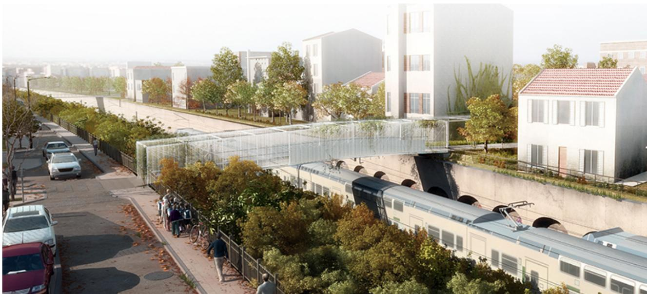
La passerelle permet le franchissement des voies ferrées sur 24,5 mètres sans appui intermédiaire. Sa structure — une poutre isostatique tridimensionnelle en acier —, est conçue pour minimiser le dénivelé entre le sol et le niveau de tablier ; ce dernier à la fois extrêmement fin et très solide, est à lui seul une prouesse technique. Large de 4 m (largeur utile de 3,60 m) avec pente maximale de 4%, il permet un accès piéton (y compris les personnes à mobilité réduite) et cycles non motorisés.
