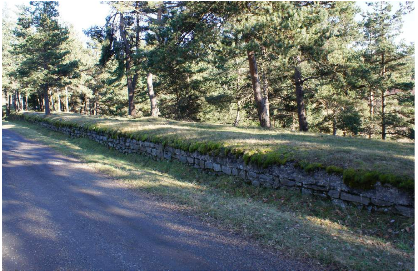
Vestiges des quais de la gare de Chabrillac
