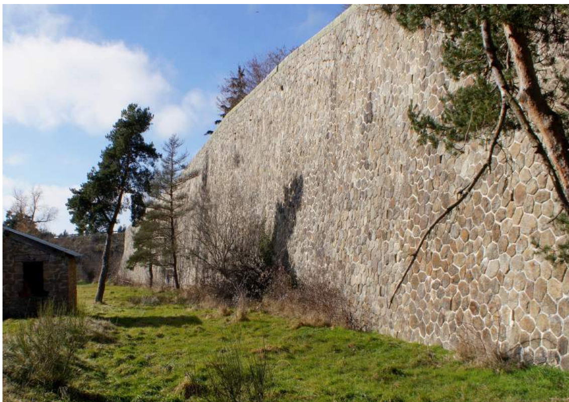
Mur de soutènement près de Chadelat
