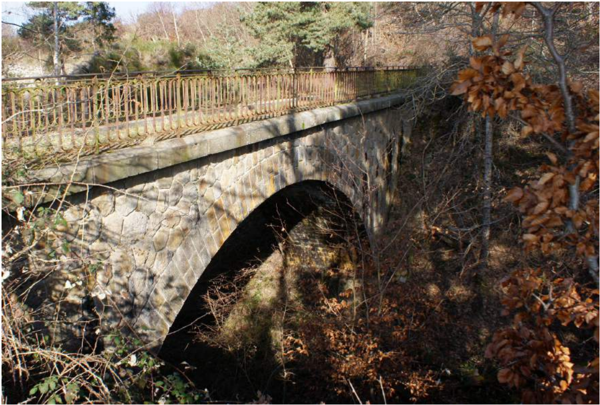
Pont près de Chadelat
