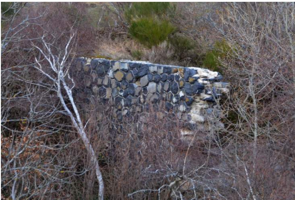
Pont en ruine près du bois des Couades
