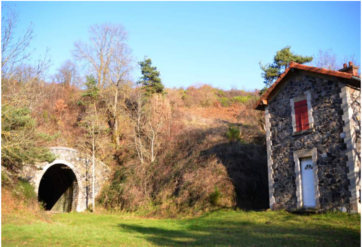
Souterrain de Verneuge, entrée sud
