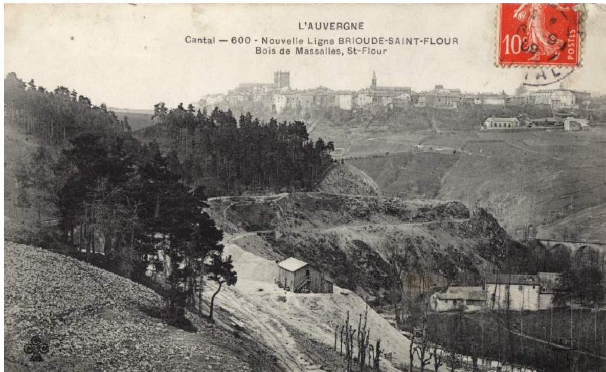
Sur la droite, le viaduc de Massalès de la ligne actuelle Saint-Flour - Neussargues Carte envoyée le 06 Septembre 1909 - Collection Anne VIGOUROUX
