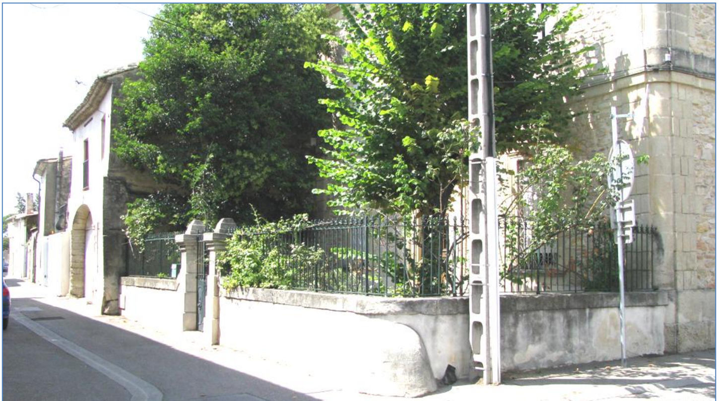
La partie Est du territoire de Vergèze rattaché à Codognan lors de l'échange (angle du chemin de la Monnaie et de la rue de Vergèze)
