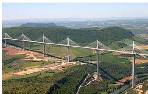
Record de hauteur, avec des pylônes culminant à 340 mètres (plus hauts que la Tour Eiffel) et long de 2 460 mètres, le Viaduc multi haubané de Millau effleure la vallée du Tarn en 9 points seulement.
