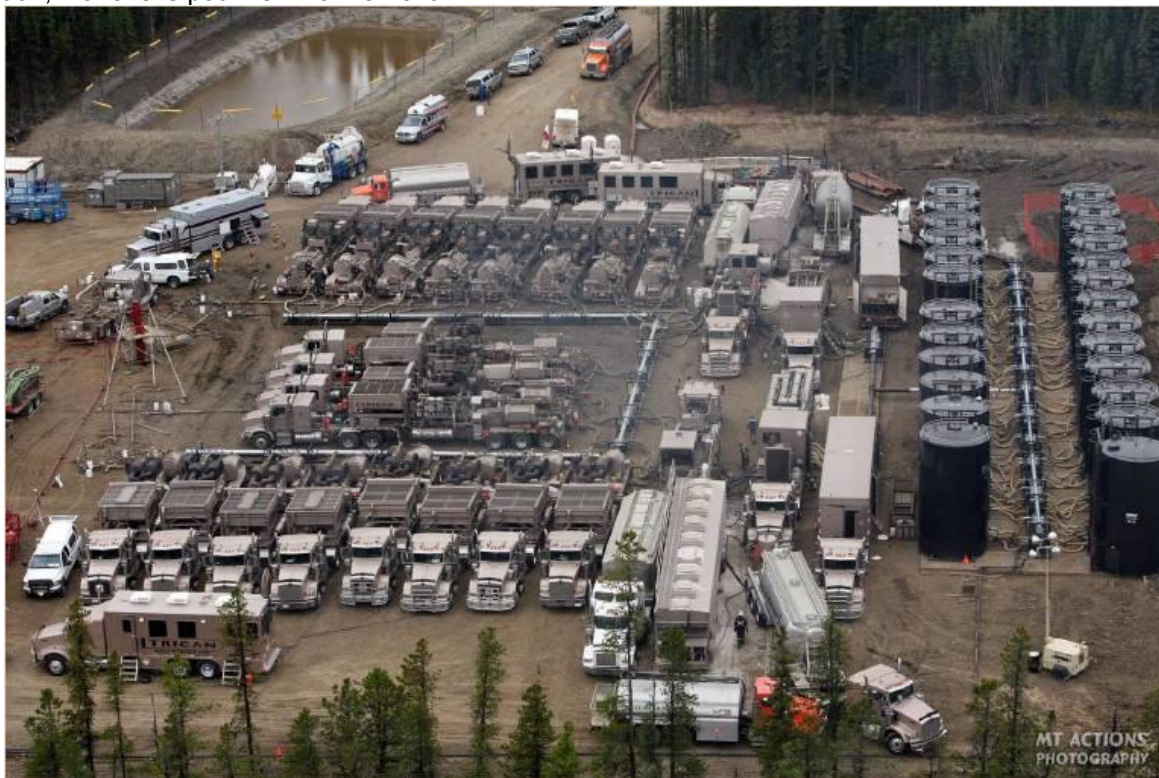
Un chantier aux USA lors de la phase de fracturation
