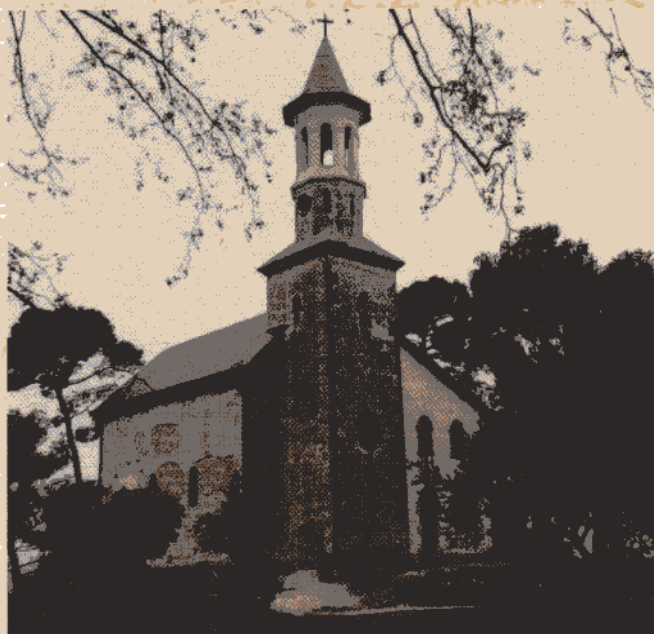
Chapelle des Orphelins Apprentis d'Auteuil à Marseille.
