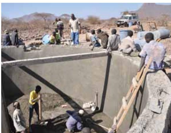
Construction d'un réservoir souterrain de récupération des eaux de pluie au nord Kenya.
