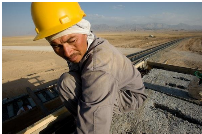
Construction d'une voie ferrée, Mazar-E-Sharif
