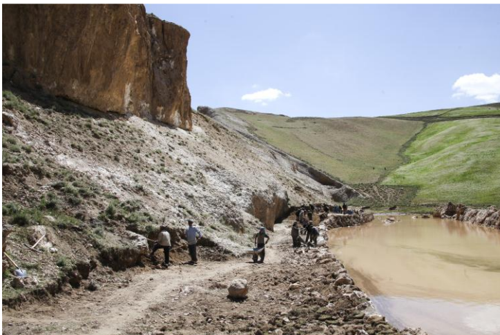
Construction d'une route dans le centre du pays
