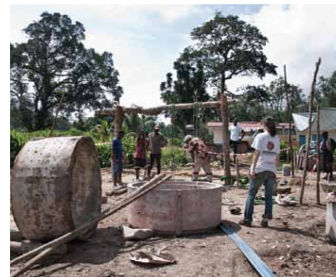
↑ Construction d'un puits, Libéria.
