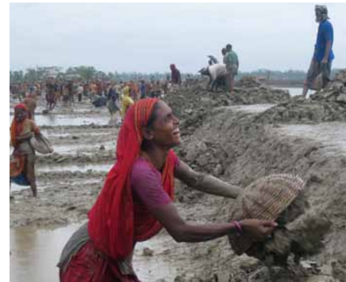
↑ Chantier de reconstruction d'une digue de protection, Bangladesh.
