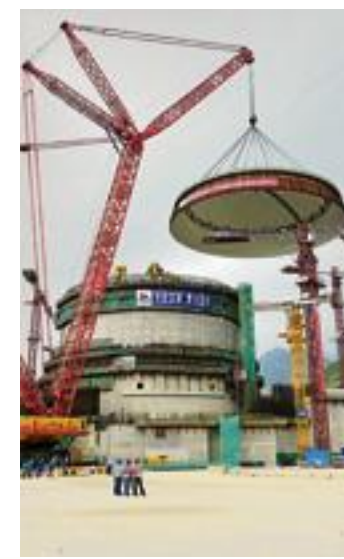
Pose du dôme sur l'un des deux EPR en construction sur le site de Taishan, en Chine.
