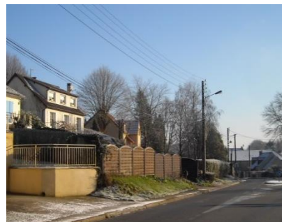
Eclairage public sur poteau électrique à Oinville-sur-Montcient
