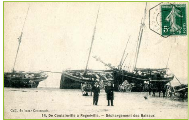
Trois sloops échoués sur la grève. Le chargement des bateaux se fait avec de petits banneaux, en raison de la faible portance du sable. Coll. R. Gouyette.
