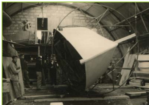
Un Scorpénic en construction sur un chantier rotatif. Cette série à bouchains vifs en contreplaqué marine a été dessinée par David Smewing. Coll. M. Smewing.
