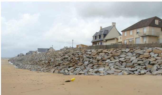
Figure 24 : Vue sur la nouvelle digue : à gauche l'enrochement (vers le Nord-est), à droite les accès piétons et voitures (vers le Nord)
