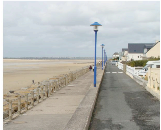
Figure 24 : Vue sur la nouvelle digue : à gauche l'enrochement (vers le Nord-est), à droite les accès piétons et voitures (vers le Nord)
