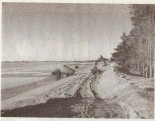
Outre le renforcement du cordon dunaire, déjà amorcé dans le secteur du Treustel une digue en terre de 1 000 mètres devait être construite cette année.
