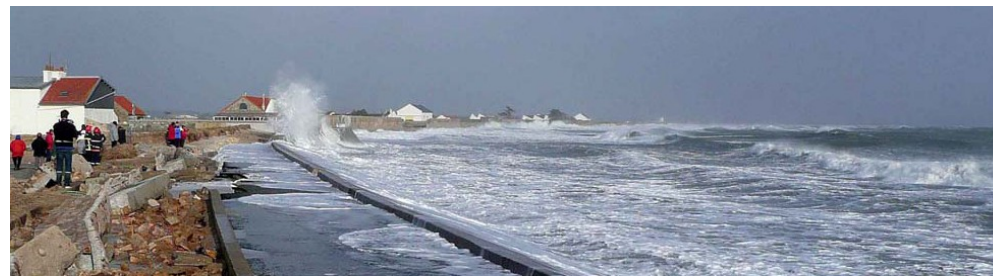
submersion marine sur la commune de Gâvres - rupture du mur de protection mars 2008
