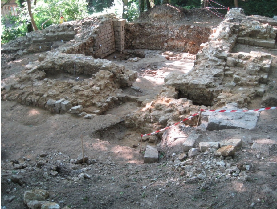
Vue de la tour en cours de dégagement. Vue du nord (Toutencourt 2010)
