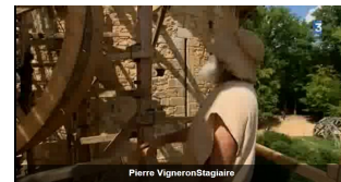
Guédelon. 14 ans de travaux déjà et toujours avec les outils et les techniques du Moyen-Age.
