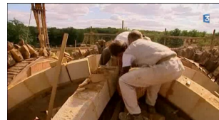
Guédelon. En 2011, la construction d'une voûte monumentale est en train de s'achever.
