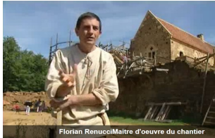
Guédelon. L'an dernier, plus de 310 000 visiteurs sont venus regarder les bâtisseurs travailler à la remise en état du château fort.
