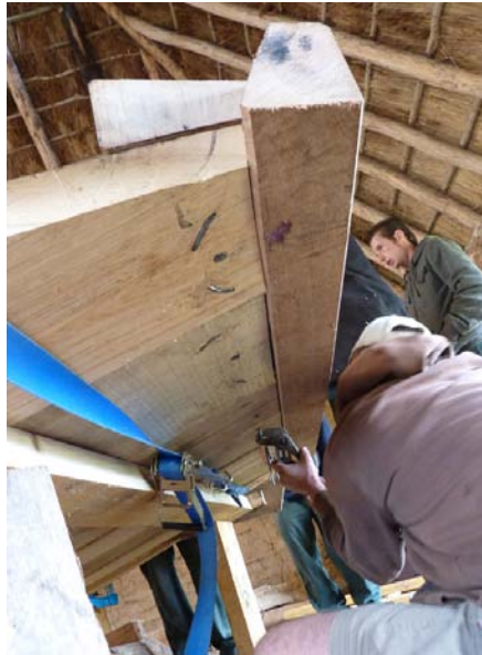
Pose du seuil de proue
