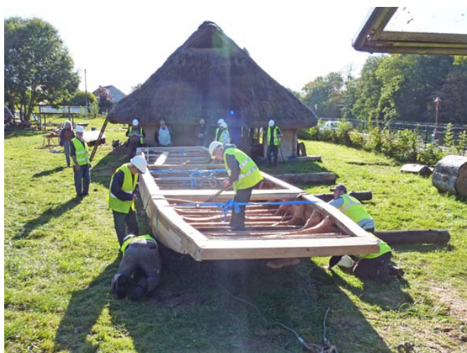
Préparation à la manipulation par la grue
