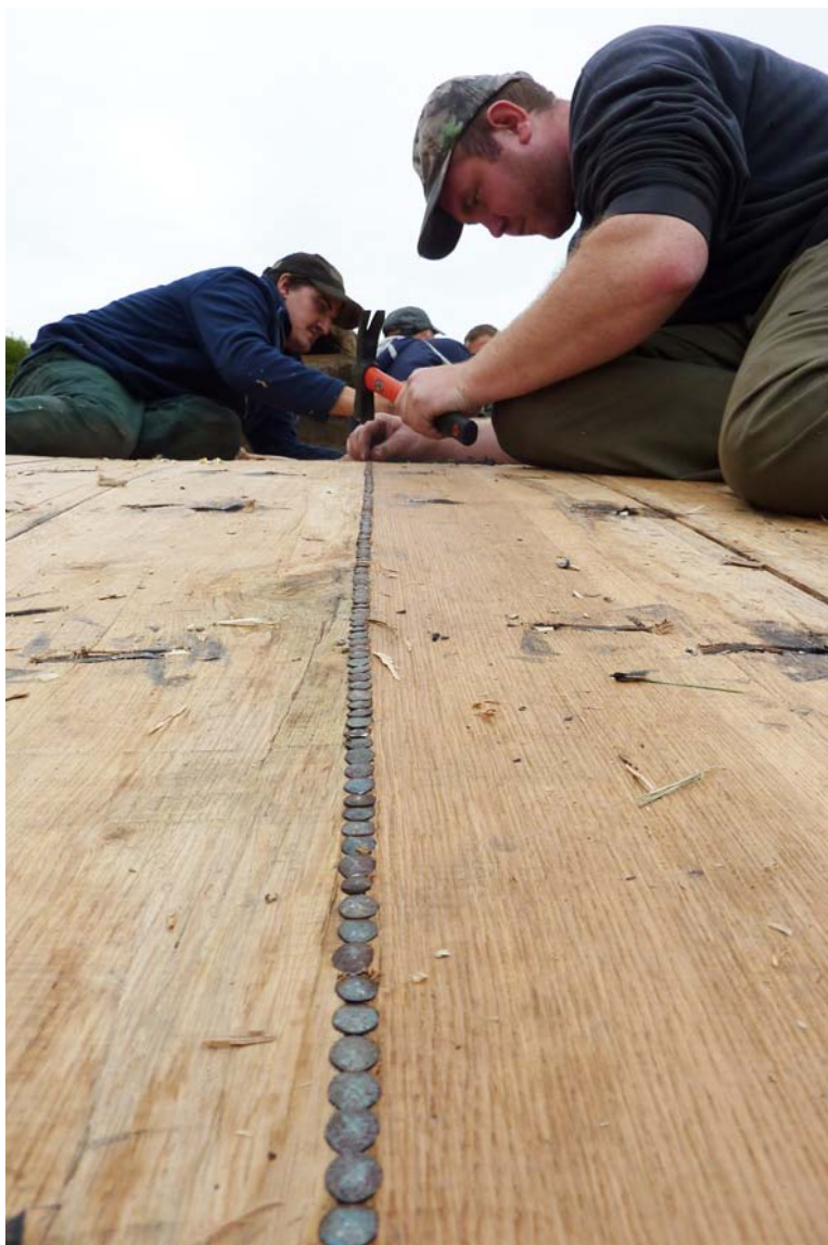
Sur le calfat, une ligne continue de clous sur chaque jointure (15 000 utilisés)
