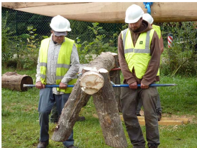
Positionnement du chantier
