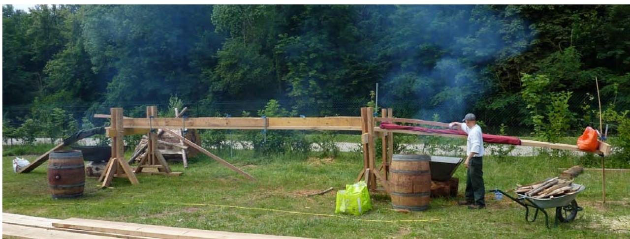
*Le banc de cintrage. A gauche, le cintrage est achevé, à droite, il est en cours. Au centre, des bastaings assurent la rectitude de la planche*
