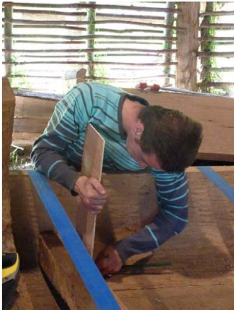
*Finition des membrures, à l'aide de gabarits et par ajustage sur leur emplacement.*
