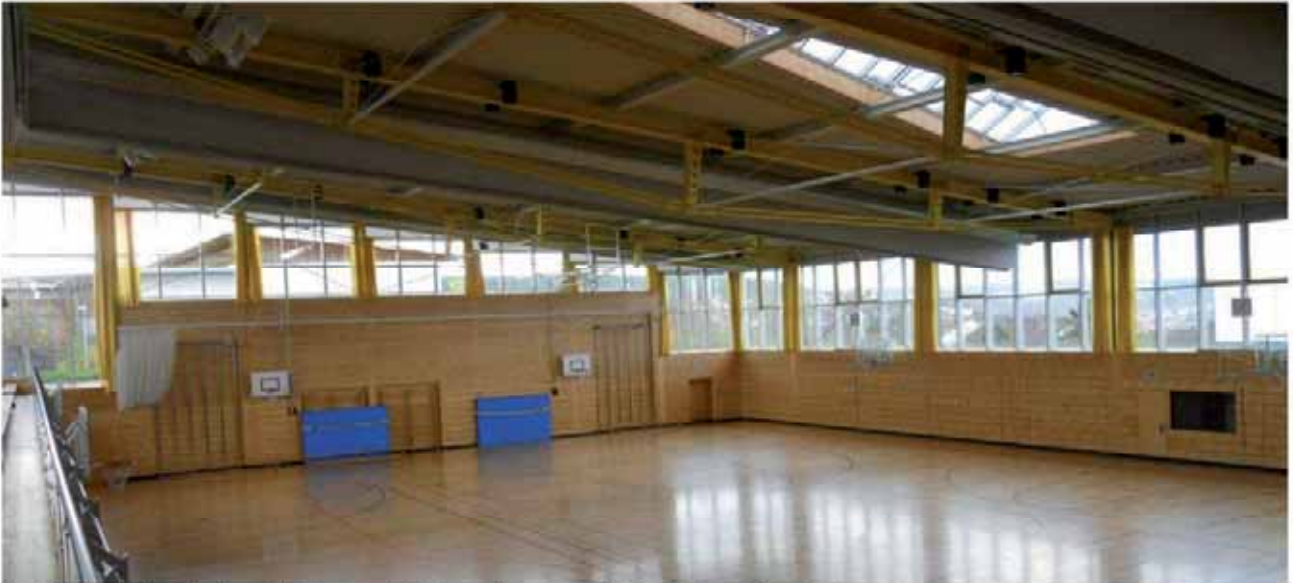
Foto5: Decke Sporthalle mit Lüftung und Dachverglasung Beleuchtung Sporthalle
