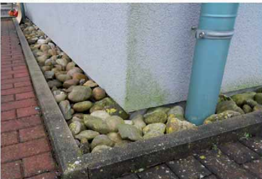
Foto5: Sockel mit vorspringendem Mauerwerk
