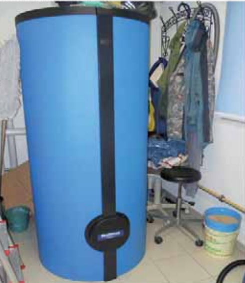
Foto10: Warmwasserboiler
