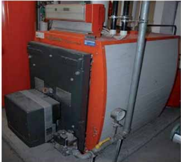
Foto 16: Niedertemperaturkessel im Heizraum
