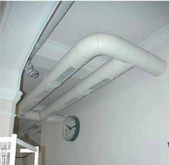
Foto 17: Lüftung im Mehrzweckraum
