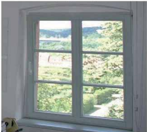
Foto 12: Fenster 1.OG, aufgeklebte Sprossen
