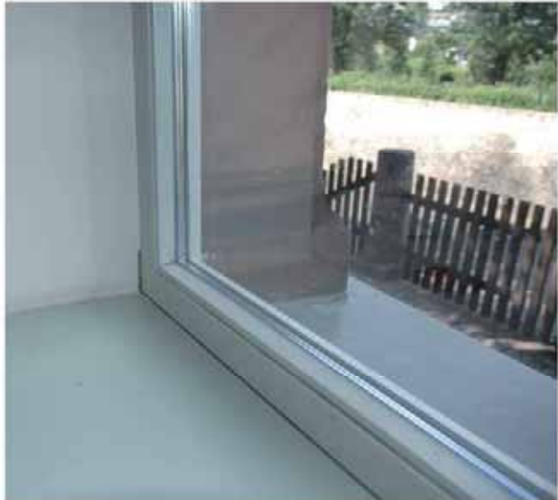
Foto 12: Fenster 1.OG, aufgeklebte Sprossen
