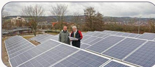
Die von der Gemeinde auf einer 600 m<sup>2</sup> großen Fläche über dem Trinkwasserhochbehälter für 90.000 € errichtete Photovoltaikanlage kann noch rechtzeitig vor dem Wintereinbruch fertiggestellt werden. Sie leistet 34.600 kWh/Jahr und erzielt einen Erlös von 8.200 Euro pro Jahr. Es können 20,8 Tonnen CO<sub>2</sub> eingespart werden.
