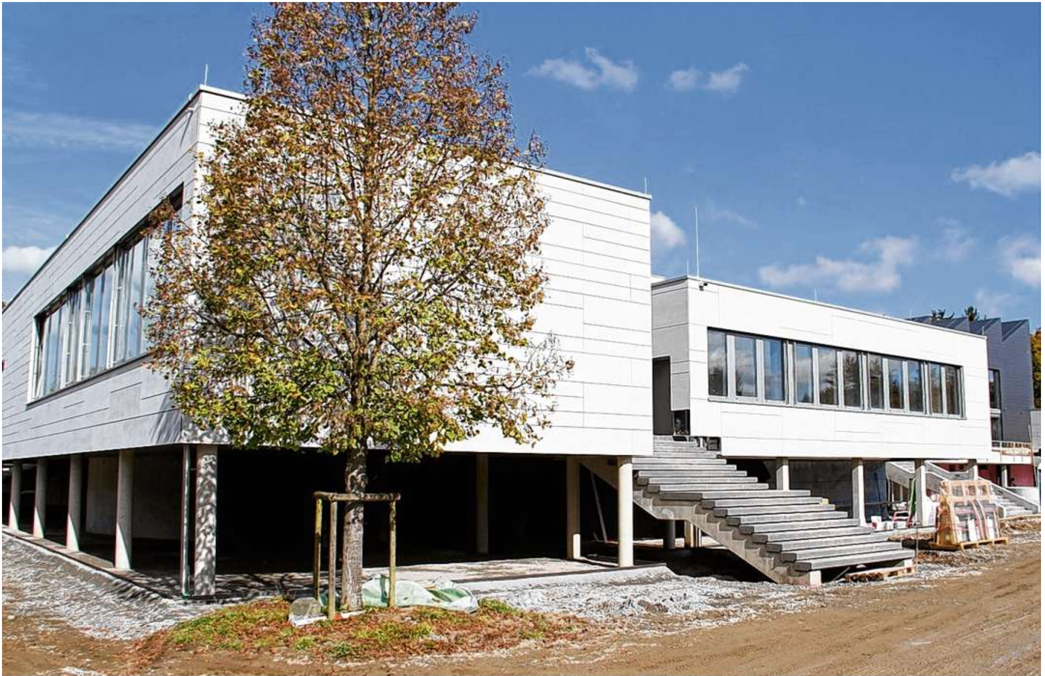
Es wird: Die Eröffnung der kernsanierten und erweiterten Mainfrankensäle ins Veitshöchheim ist für Januar 2015 geplant. Von außen jedenfalls, hier die Fassade am Seiteneingang, sieht vieles schon gut aus. Doch noch müssen viele Arbeiten geleistet werden – innen wie außen. Der Zeitpuffer jedenfalls schrumpft mächtig zusammen. FOTOS: DIETER GÜRZ
