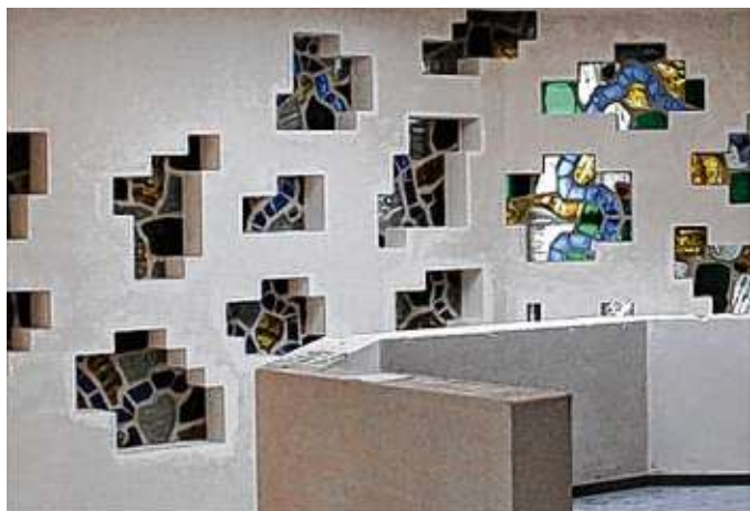
Sie wurden erhalten: die Glasbausteine am Treppenberg.
