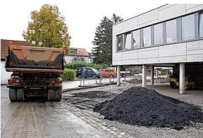
Neu aufgetragen: Asphaltierungsarbeiten an den Außenanlagen.
