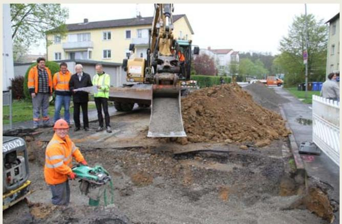
Aufgrund des äußerst schlechten Zustands des Fahrbahnbelags und der Gehwege sowie des nicht tragfähigen und frostempfindlichen Oberbaus wird die Heidenfelderstraße von der Kreuzung Wolfstalstraße bis zum Danziger Platz auf eine Länge von 300 m neu ausgebaut. Die Fahrbahn- und Gehwegbreiten von 6 m bzw. 1,50 m sowie die wechselseitig angeordneten Parkflächen können erhalten bleiben, nicht zuletzt um die Kosten zu minimieren.
