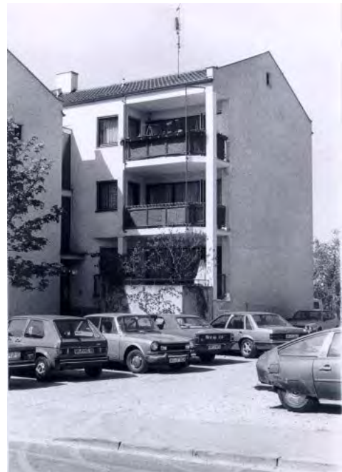
Wohngebäude in der Bahnhofstraße
