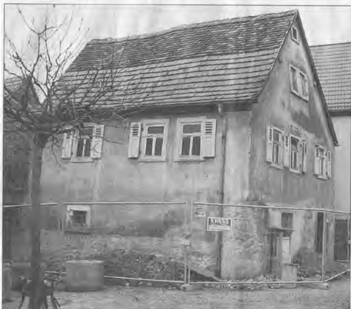
Der Schandfleck an der Ecke Kirchstraße/Obere Maingasse soll beseitigt werden: Demnächst rücken die Bagger an und reißen das Haus und die dahinterliegende Scheune ein. FOTO DIETER GÜRZ
