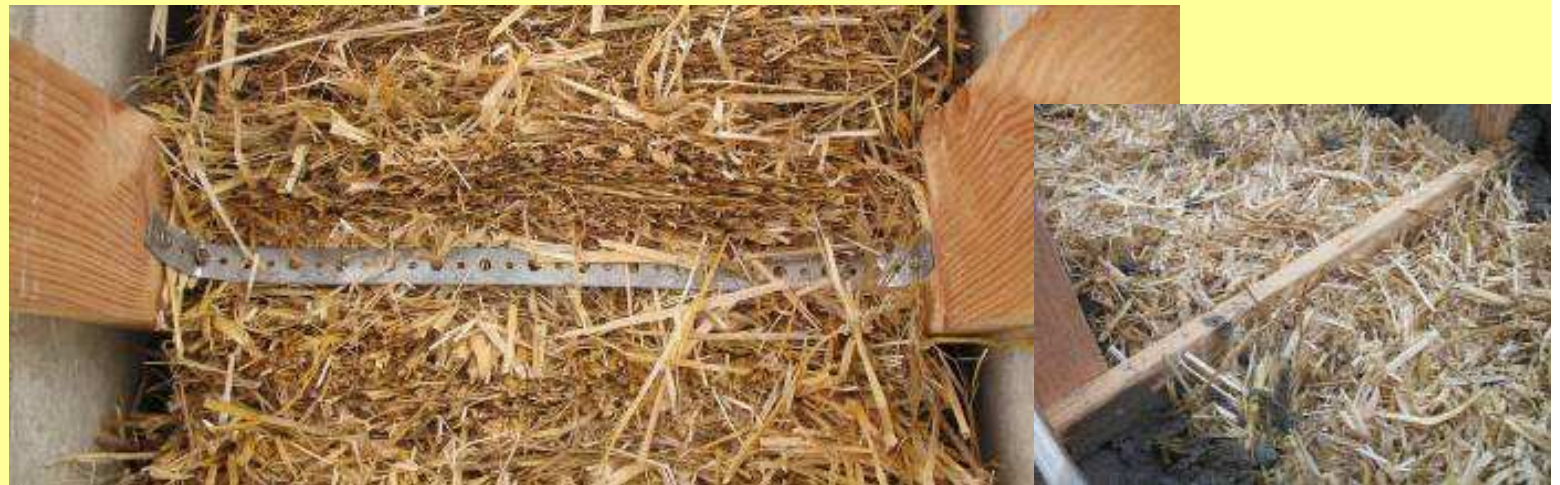
Les tirants métalliques (Bois/paille/bois)
