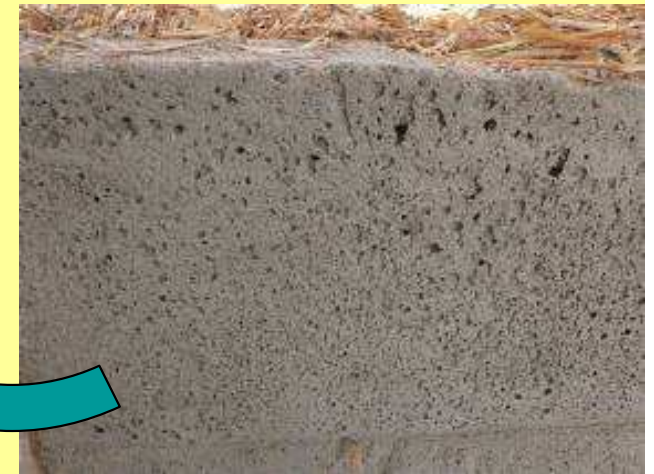
4-Le mortier allégé, coulé
