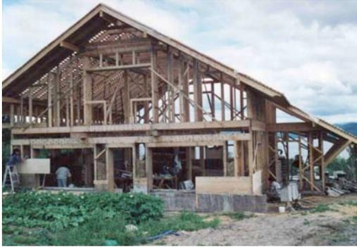
**Photo 45** : Comme avec l'autre type de charpente de toit expérimenté, il est nécessaire de prévoir les pièces pour les avancées de toit. On procède de la même façon que pour le type de charpente précédente. *Photo: Dominique Poirat*
