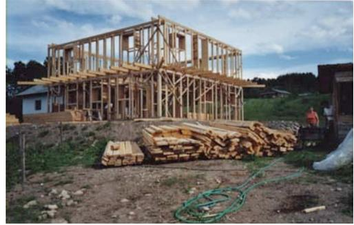
**Photo 19 :** Notez les sablières est et ouest plus hautes. Elles sont plus hautes pour permettre l'installation des poutres sur les sablières nord et sud. Ces poutres seront nécessaire pour l'installation des fermes du toits (voir la section toit).
