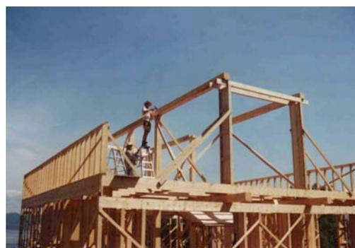
**Photo 40** : Des murets de 4 pieds de haut en 2x6 ont été ajoutés sur les solives de plafond/plancher pour rehausser le toit et faire plus de place au demi-étage et supporter les côtés du toit. Une charpente lourde en 8 par 8 ainsi que des 4 « poteaux » et 4 linteaux de charpente double (pour les pignons en ballots de paille) supporteront le centre du toit. Le tout est bien contreventé pour empêcher le déplacement de l'ensemble.
