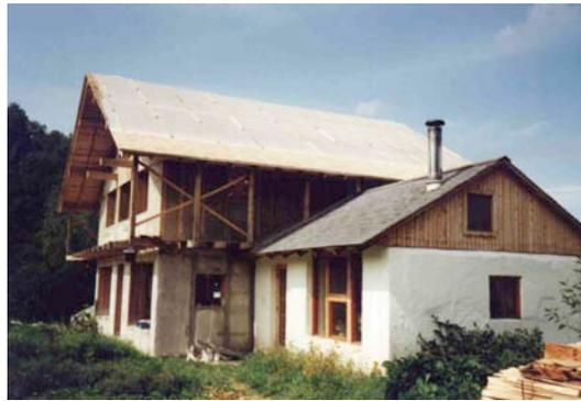
**Photo 36** : Le plastique peut être installé et fixé avec des 1x3 perpendiculaires à tout les 6 pieds par dessus le lattage avant le coulage des murs si l'on ne pose pas les bardeaux avant. Il protégera des intempéries l'ensemble de la construction ainsi que les travailleurs. Ceci permet aussi de protéger la paille et de travailler peut importe la température. On se fait livrer la paille à ce moment seulement. *Photo: Patrick Déry*
