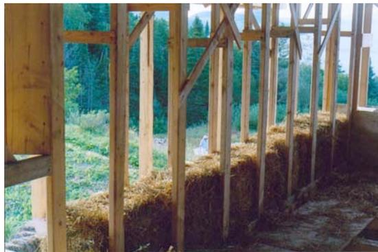
**Photo 22 :** Après la pose des ballots à l'extérieur du mur. Notez les contreventements qui ont été sciés pour permettre la pose des ballots et l'installation des coffrages. Les 2x3 permettant le maintien de la distance de 15 pouces entre les 2x4 (colombage) doivent demeurer en place le plus longtemps possible durant le coulage. Pose des clous et des tirants.
