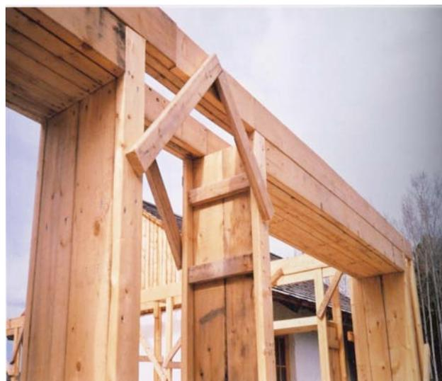
**Photo 14 :** Là encore, on voit le haut du faux cadre d'une fenêtre sud, l'assemblage des « poteaux » (2x4 et 2x8), ainsi que l'installation des sablières linteaux sur ces « poteaux ».
