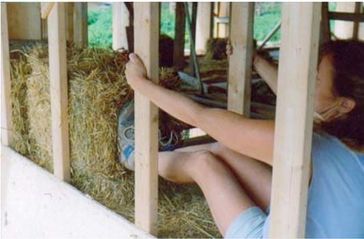
**Photo 20 :** Les ballots de paille doivent être posés les plus serrés possible entre eux. Les ballots doivent être le plus sec, le plus dense et le plus uniforme possible. Pour la pose des ballots, il faut attendre que la charpente soit totalement terminée et qu'un plastique ou que la couverture soit installée (voir section du toit).
