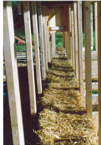
**Photo 21 :** Après la pose des ballots, à l'intérieur du mur.
