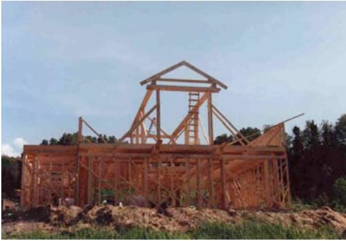
**Photo 41** : Sur les poutres, on installe les triangles de faîte. *Photo: Dominique Poirat*
