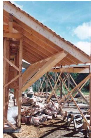
**Photo 46** : Sur le côté est de cette maison, le débord de toit est imposant et permet la protection de bois de chauffe. Des équerres sont alors nécessaires pour tenir en place cette partie du toit. *Photo: Dominique Poirat*
