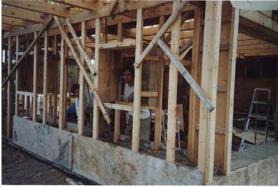
**Photo 23 :** Les coffrages installés par dessus les 2x4 et recouvrant les ballots. Il reste une distance approximative de 1,5 à 2 pouces entre les ballots et les coffrages. À cause du poids relativement faible du mortier (p/r au béton), le coffrage peut être fixé uniquement par 3 vis sur chaque 2x4.
