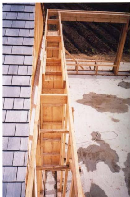
**Photo 12 :** Vue du haut d'une sablière simple. On peut y remarquer plusieurs choses. D'abord, les sablières sont supportées par des bouts de 2x6 (d'une longueur d'environ 15 pouces) perpendiculaires à celle-ci. Ensuite, les sablières sont doublées en haut de la porte pour former des linteaux. On y voit aussi la charpente du bas d'une grande fenêtre *Photo: Patrick Déry*
