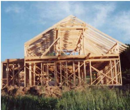
**Photo 43** : Le toit intérieur est presque entièrement terminé. Il reste à poser les chevrons sur l'entrée de la maison. *Photo: Dominique Poirat*
