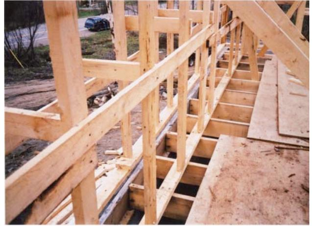
**Photo 9** : Pose de la lisse et du colombage sur un solage conventionnel. Sur un solage conventionnel, c'est la même chose que sur une dalle flottante. Des bouts de 2x3 sont installés d'un 2x4 à l'autre pour conserver la bonne distance (15 pouces) entre ces derniers. Ils seront enlevés lors du coulage. Les contreventements sont installés temporairement pour solidifier la charpente en attendant le coulage du mortier qui viendra tout solidifier. *Photo: Alain Brochu*
