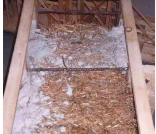
**Photo 24 :** Photographie d'une maquette où l'on voit très bien la disposition d'un tirant sur le ballot avant la pose de la prochaine rangée.
