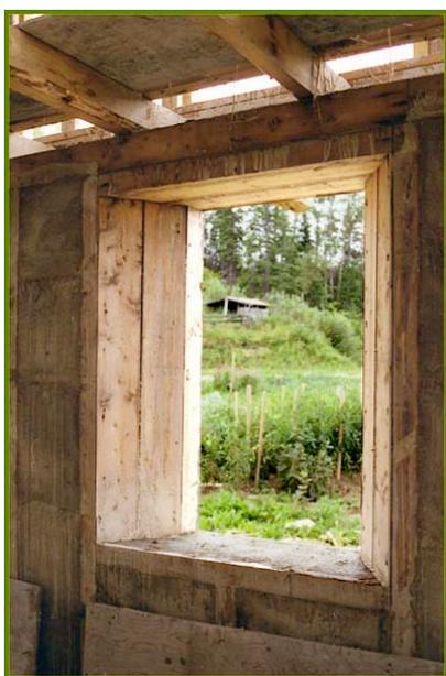
**Photo 16** : Une variante du cadrage droit de petite fenêtre (moins de 36 pouces) est un cadrage à angle. Les 2x4 (colombage) extérieurs sont installés à la bonne distance comme pour une fenêtre droite, mais les 2x4 intérieurs sont décalés de quelques pouces selon l'angle que l'on veut donner à l'ouverture. *Photo: Pierre Gilbert*
