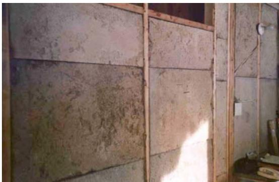
**Photo 50** : Division en blocs de mortier.
