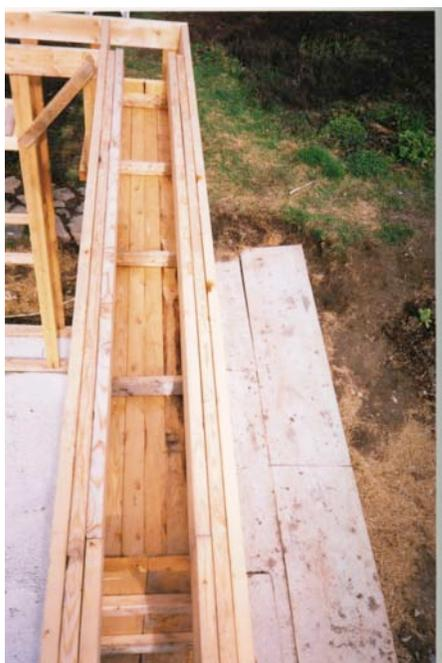
**Photo 13 :** Ces sablières ont été triplées parce que c'est le mur sud et qu'il est composé essentiellement d'ouvertures. On voit aussi, entre les linteaux, le haut du faux cadre d'une fenêtre sud. On voit bien le coin des sablières. *Photo: Patrick Déry*
