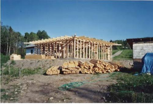
**Photo 18 :** La charpente du rez-de-chaussée. Notez les contreventements doivent être supérieur en nombre pour monter l'étage (très important).
