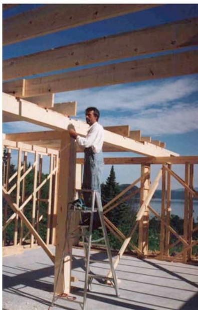
**Photo 39** : Pose des solives sur les poutres. Notez les pièces de 2x4 posées sur les poutres et sous les solives. Elles permettent d'encastrer les lattes et les planches de finition entre les solives et les poutres (esthétique).
