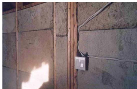
**Photo 51** : Division en blocs de mortier avec boîte et fils pour l'électricité. Photo: Patrick Déry
