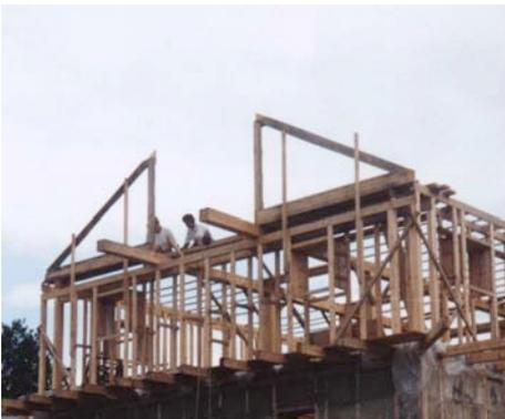
**Photo 31** : Sur cette photo, c'est l'installation des 2 triangles de côté. Notez les pièces empêchant le basculement des triangles vers l'extérieur qui peut être très dangereux. Notez aussi les poutres de support qui dépassent et qui serviront au futur balcon.
