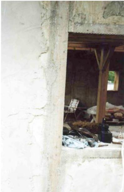
**Photo 27** : Sur cette photo, les 2x4 sont recouvert d'un treillis métallique (à stucco) car le crépis ne colle pas sur le bois. Toutes les surfaces de bois (faux-cadre de fenêtre ou de porte,...) doivent être recouverte de treillis. On remarque aussi que le crépis de chaux a été appliqué sur une partie du mur.
