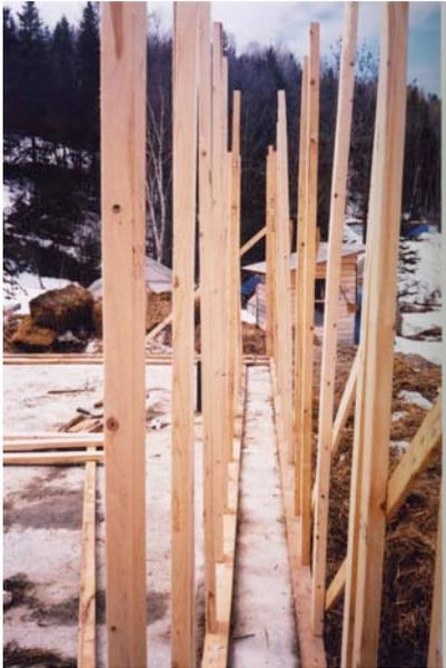
**Photo 8** : Pose de la lisse et du colombage sur une dalle flottante en béton. Les lisses en 2x4 se placent à plat au sol, les bords extérieurs à 18 pouces de distance ce qui laisse 15 pouces à l'intérieur du mur pour insérer les ballots de paille. Les pièces de colombage en 2x4 se placent l'un face à l'autre sur le bord extérieur de chaque lisse. On les installe à tous les 2 pieds. *Photo: Patrick Déry*
