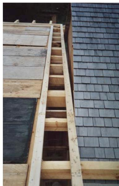
**Photo 17** : Après la pose des solives de plancher sur la charpente du rez-de-chaussée, on installe, par dessus celles-ci, les lisses de l'étage (si on en a un). Elles se posent comme au rez-de-chaussée, mais il est préférable de la doubler si la distance entre les solives est supérieure à 2 pieds. *Photo: Patrick Déry*
