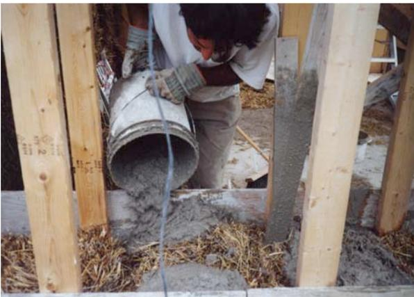
**Photo 25 :** On coule le mortier entre les 2x4, le coffrage et le ballot de paille. Il faut couler successivement d'un bord et l'autre pour empêcher le ballot de « tasser » du côté où il n'y a pas de mortier. Il faut bien fouler le mortier avec un 1x3 pour s'assurer qu'il n'y a pas de poche d'air. La recette du mortier est, en volume : 1 ciment portland, 1 chaux aérienne (chaux Limo), 2 sable et 3 sciure de bois (peu importe l'essence).
