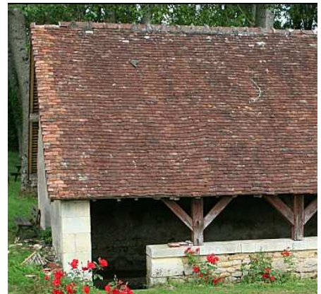
Septembre 2012 –arrêt des travaux
