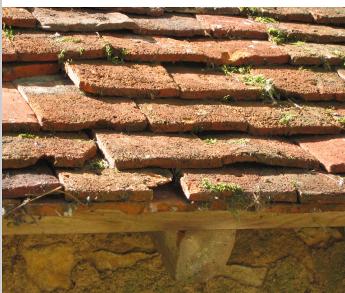
Été 2012—réalisation des travaux
