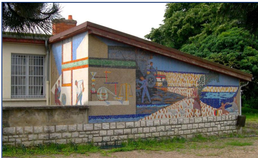
La mosaïque sur le mur de façade et son retour
