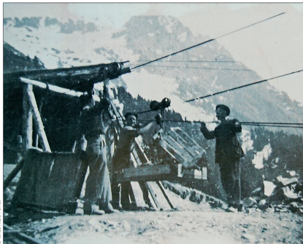
Au départ du treuil de descente des ardoises, dans les derniers temps de l'exploitation (Cevins).
