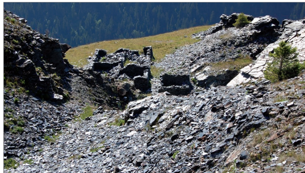
Installations en ruine sur le site des anciennes ardoisières (Cevins).
