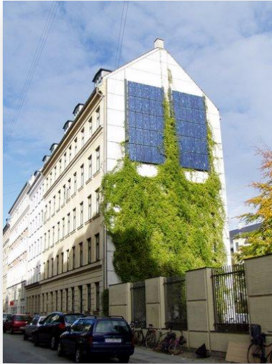
FIG. 11 : PANNEAUX SOLAIRES ET VEGETALISATION DES FAÇADES www.ebst.dk
