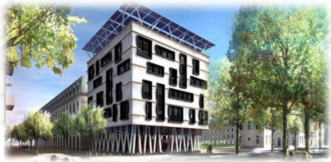
FIG. 15 : LES BESOINS EN CHAUFFAGE DU « BATIMENT A ENERGIE + » SETONT LIMITEES A 10KWH/M 2 /AN www.debonne-grenoble.fr
