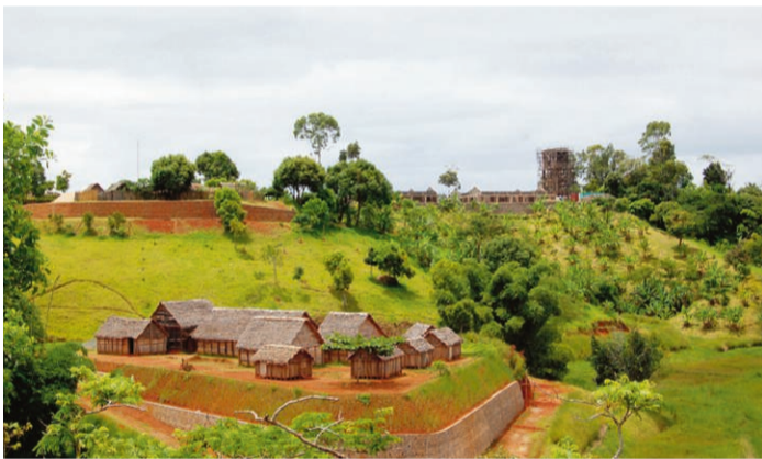
À la pelle et à la pioche, il a fallu plusieurs années pour transformer les collines en plateformes consolidées par 700 m de murs de soutènement.
