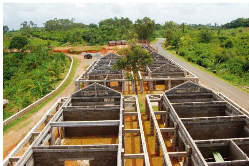
Pour alimenter l'hôpital en électricité, une ferme photovoltaïque est actuellement à l'étude.
