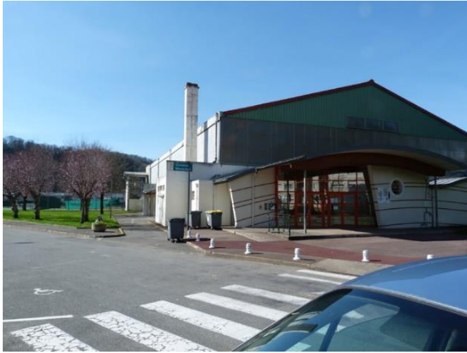
Gymnase de Jurançon
