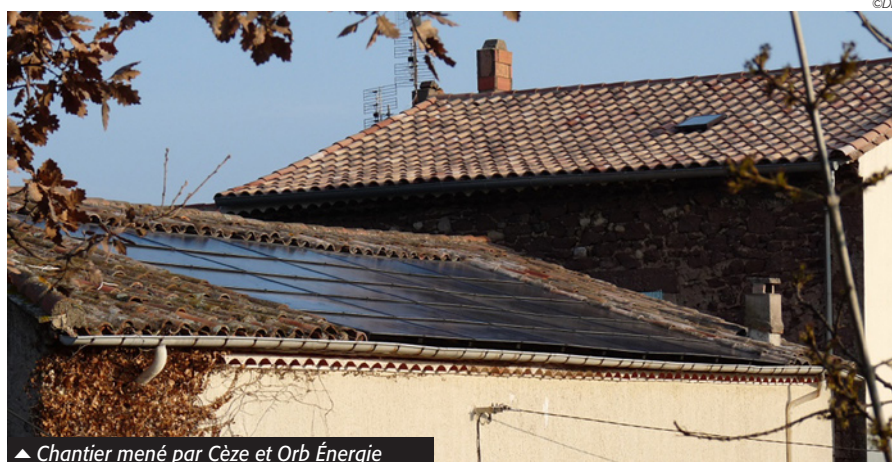
▲ Chantier mené par Cèze et Orb Énergie
