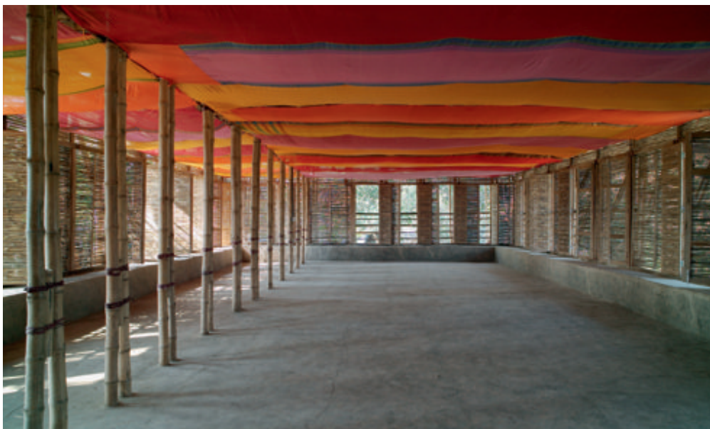
La grande salle de l'étage est destinée aux activités physiques. Son plancher est constitué de trois couches de tiges de bambou, disposées à plis croisés pour assurer le contreventement. Une couche de terre sur des planchettes en bambou sert de chape et de sol. The large room on the upper floor is intended for physical activities. Its floor comprises three layers of bamboo poles, cross-folded together for bracing. An earth layer on bamboo slats is used as a levelling and surfacing course.
