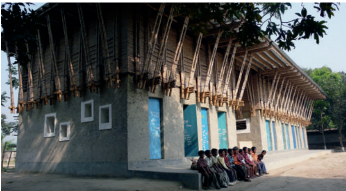
Les encadrements de baie ont reçu un enduit à la chaux qui tranche sur la couleur naturelle de la terre. The frames of the openings have been treated with a lime render, which contrasts sharply with the natural colour of the earth.
