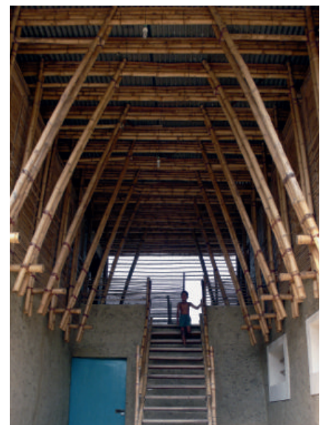
L'étage offre de larges vues sur les rizières. The upper floor offers unrestricted views onto the paddy fields.
