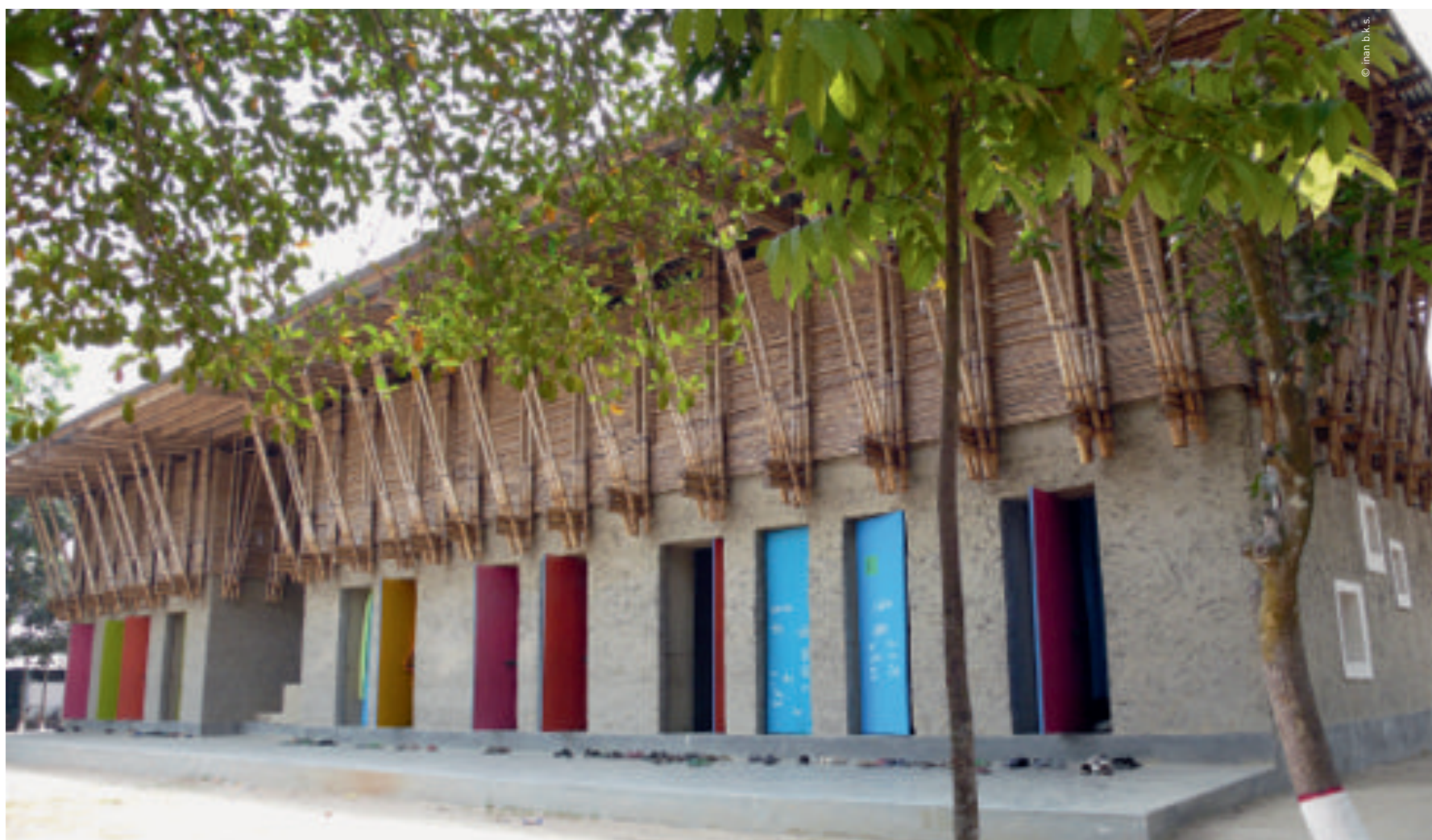
Sur le rez-de-chaussée en boules de terre empilées de l'école est posée une ossature en tiges de bambou. Les parois, les fenêtres et les portes de cet étage sont en bambou tressé. A framework of bamboo poles is laid on the ground floor of the school, made out of stacked clods of earth. The wall, windows and doors on this level are made out of woven bamboo.
