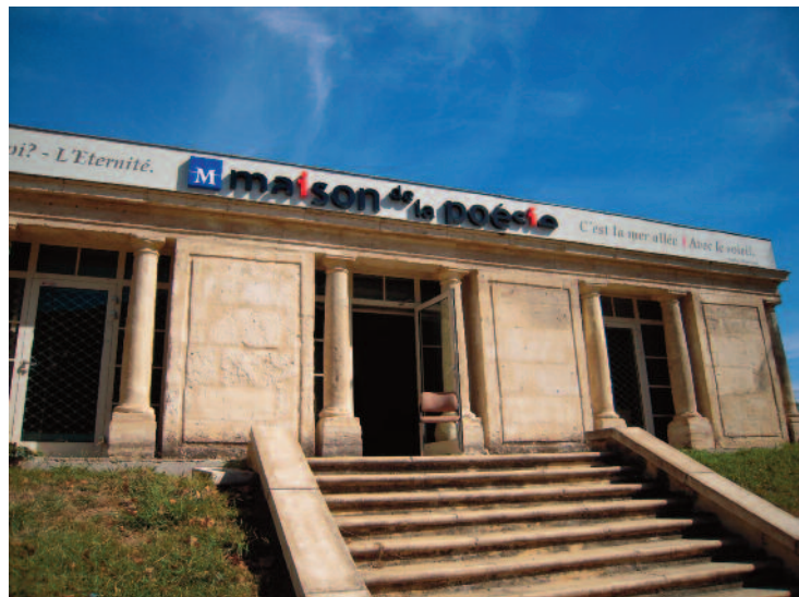
Photo : mairie de Montpellier
