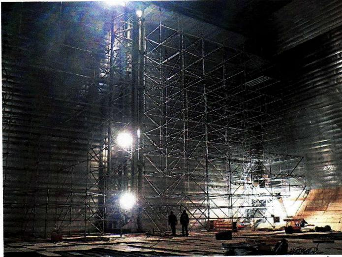
Les travaux à l'intérieur des cuves de méthaniers se particularisent par l'impérieuse nécessité de ne pas endommager les membranes de 0,7 à 1,2 mm d'épaisseur fragiles aux chocs, aux rayures et à l'oxydation : ordre, propreté, méthodologie, assurance de la qualité ajoutés à une technologie élaborée font la « différence » qui qualifient SOBRENA pour ce type d'interventions.
