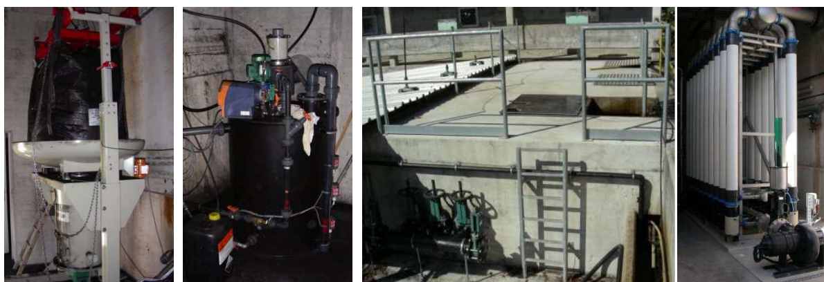
Figure 11 : Photo 1 (à gauche) : « big bag » de CAP sur un support vibreur qui amène la poudre dans le bac de préparation de la solution de CAP (photo 2) ; photo 3 : réacteurs de contact du CAP avec les eaux usées ; photo 4 : membranes d'ultrafiltration pour la séparation du CAP.
