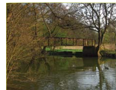
Passerelle métallique de Périgny-sur-Yerres
