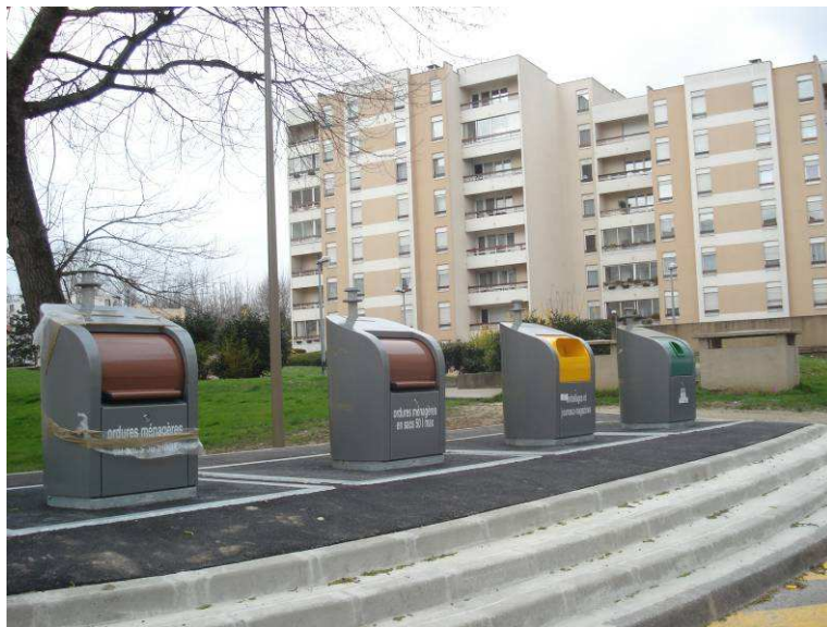
Bornes enterrées à la résidence de Cernay
