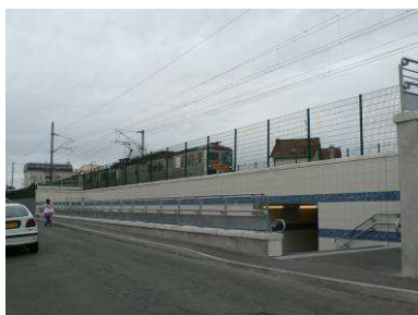
Passage piétons souterrain (Rue de l'Orme Saint Edme à la rue Balzac)
