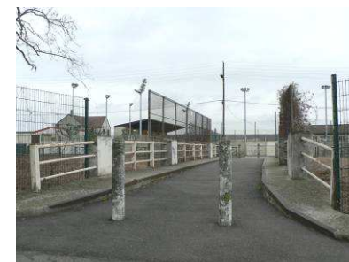
Passage piétons au dessus de la voie ferrée (Avenue des Marais)
