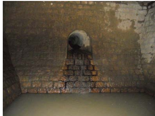
Intérieur du bassin – Arrivée conduite amont
