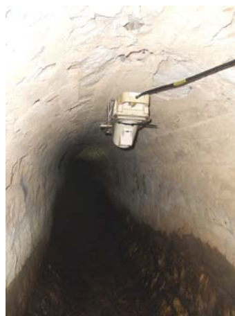
Flodar installé dans l'ovoïde 1000 mm (test en cours)
