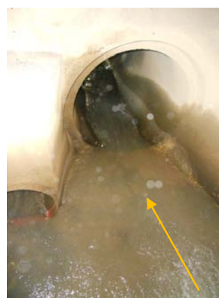
Conduites de rejet vers la Banquière
