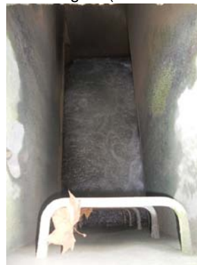
Intérieur du regard (avant déversoir)
