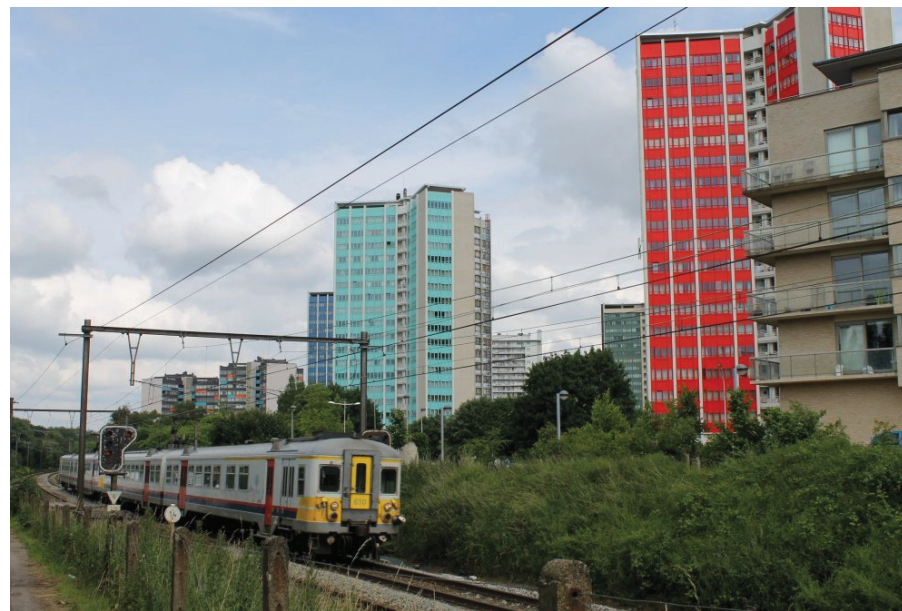
Ganshoren ( Veroost) : halte à créer, accès au parc Baudouin, accès pédestre à l'UZ, Quartier des Villas
