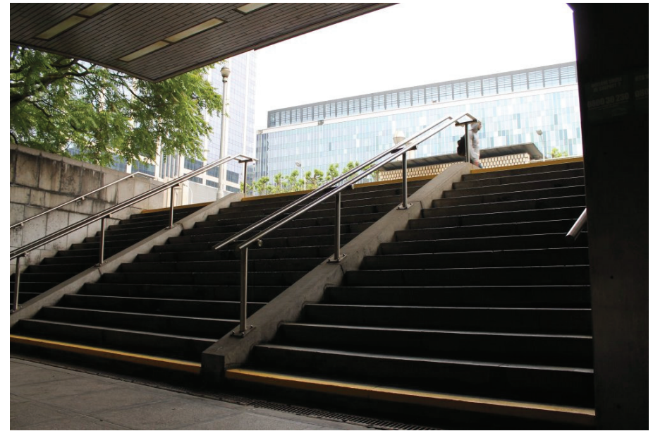
Congrès : halte existante – accès rue Neuve, Cité administrative (développements résidentiels en projet)
