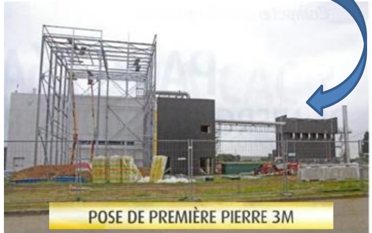
Pose de la première pierre de l'extension de l'usine 3M le 4 juillet 2013. Investissement de 12,5 M€ en première tranche. La CAC, la CCOC, la Région, l'État et l'Union Européenne accompagnent la société dans son développement.
